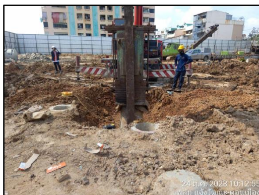
รูปที่ 29 การทดสอบการรับน้ำหนักของเสาเข็ม (Dynamic Load Test) และการติดตั้งเสาเข็ม
