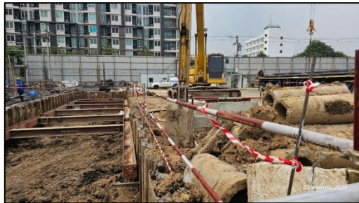
รูปที่ 31 ผนังกันดิน แบบ Sheet Pile
