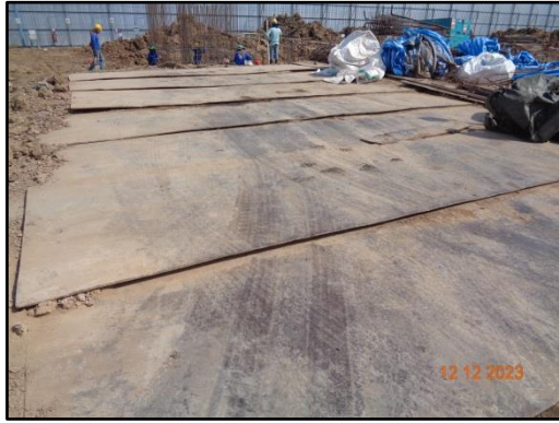
รูปที่ 54 พื้นที่สำหรับงานขนย้ายวัสดุก่อสร้าง และพื้นที่สำหรับจอดรถบรรทุกภายในโครงการ
