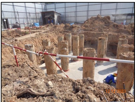
รูปที่ 12 เปิดพื้นที่ขุดดินเท่าที่จำเป็นเท่านั้น และต้องปิดหน้าดินด้วยคอนกรีตหรือปิดคลุมด้วยผ้าใบ
