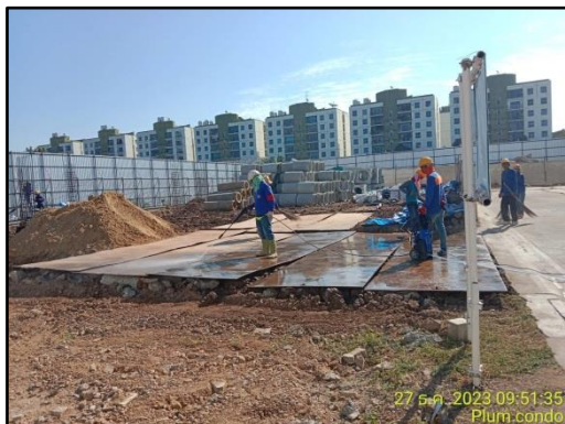
รูปที่ 8 ติดตั้งระบบสเปรย์น้ำรอบบริเวณพื้นที่ก่อสร้าง
