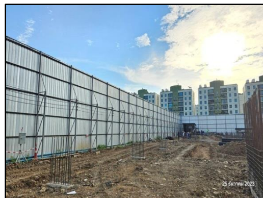
รูปที่ 2 (ต่อ) รั้วทึบ (Mesh Sheet) ความสูง 6 เมตร โดยรอบพื้นที่โครงการ
