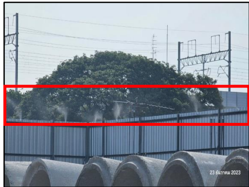
รูปที่ 8 ติดตั้งระบบสเปรย์น้ำรอบบริเวณพื้นที่ก่อสร้าง
