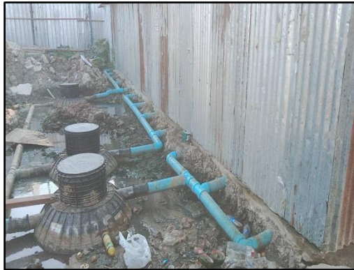
รูปที่ 37 ถังบำบัดน้ำเสียสำเร็จรูป บริเวณบ้านพักคนงาน
