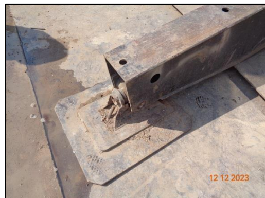
รูปที่ 27 แผ่นเหล็กปูรองเครื่องจักร
