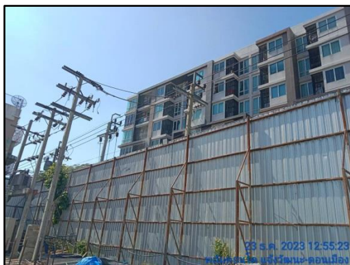
รูปที่ 2 (ต่อ) รั้วทึบ (Mesh Sheet) ความสูง 6 เมตร โดยรอบพื้นที่โครงการ
