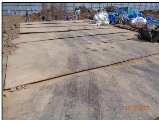
รูปที่ 27 แผ่นเหล็กปูรองเครื่องจักร
