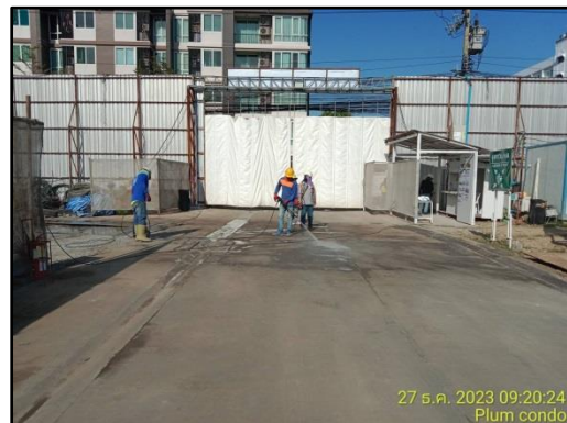
รูปที่ 8 ติดตั้งระบบสเปรย์น้ำรอบบริเวณพื้นที่ก่อสร้าง
