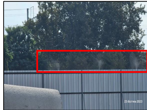
รูปที่ 8 ติดตั้งระบบสเปรย์น้ำรอบบริเวณพื้นที่ก่อสร้าง
