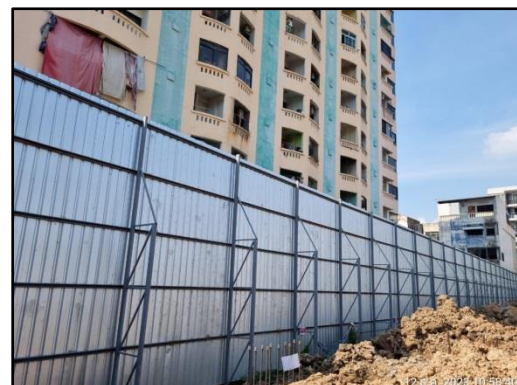
รูปที่ 2 รั้วทึบ (Mesh Sheet) ความสูง 6 เมตร โดยรอบพื้นที่โครงการ
