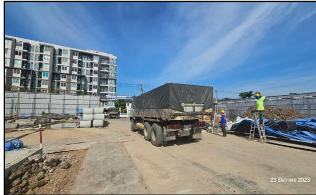
รูปที่ 10 รถบรรทุกที่ใช้ขนส่งวัสดุก่อสร้าง หิน ดิน ทราย ปิดคลุมด้วยผ้าใบ
