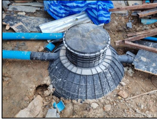
รูปที่ 36 ถังบำบัดน้ำเสียสำเร็จรูป บริเวณพื้นที่ก่อสร้างโครงการ
